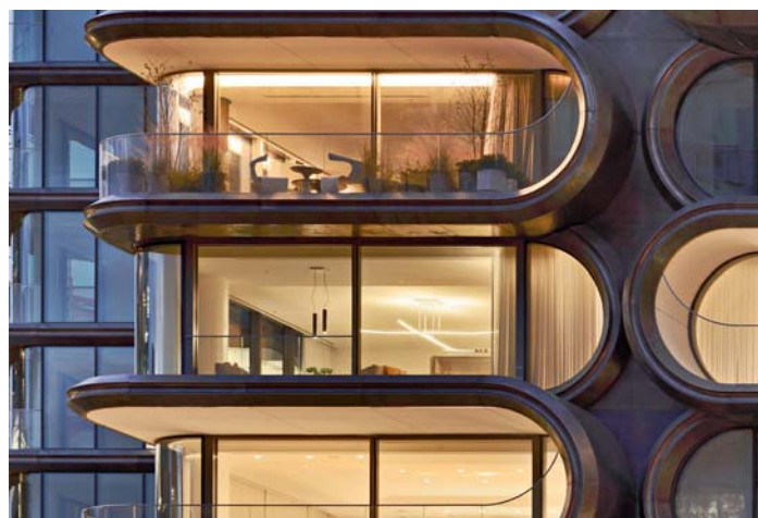
Foto © Oskar Da Riz, courtesy Stahlbau Pichler
